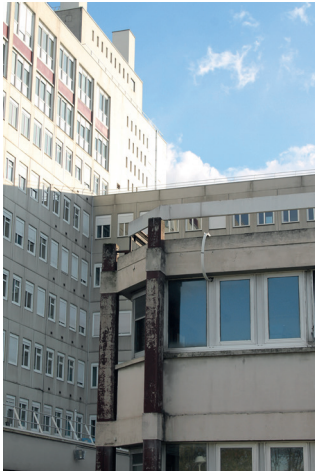
Détails de façade
