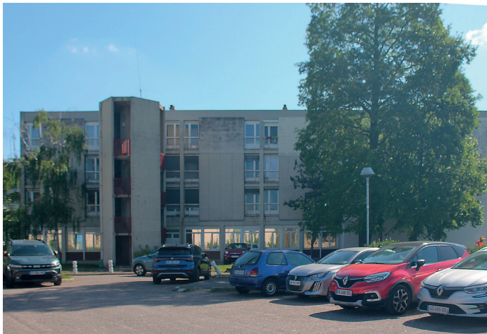
L'IFSI ; façade ouest
