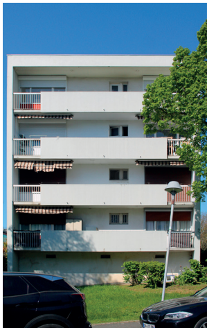
Façade est du bâtiment L
