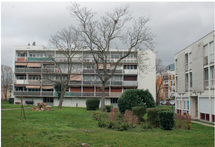
Vue du jardin et du bâtiment L
