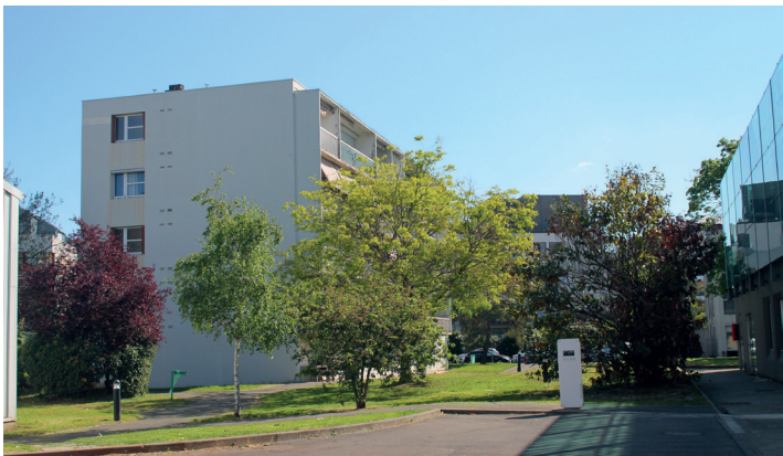
Accessibilité du coeur d'îlot ; la zone de déserte du restaurant
