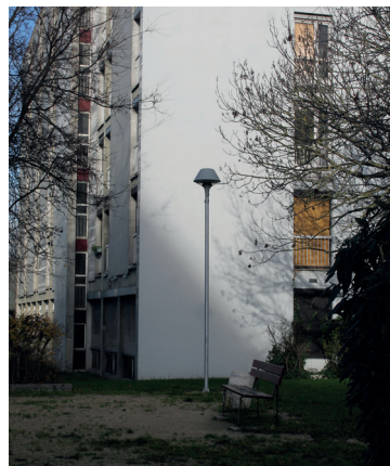
Mobilier extérieur devant le pignon sud du bâtiment F. Espace de pause pour les soignants et habitants du site.
