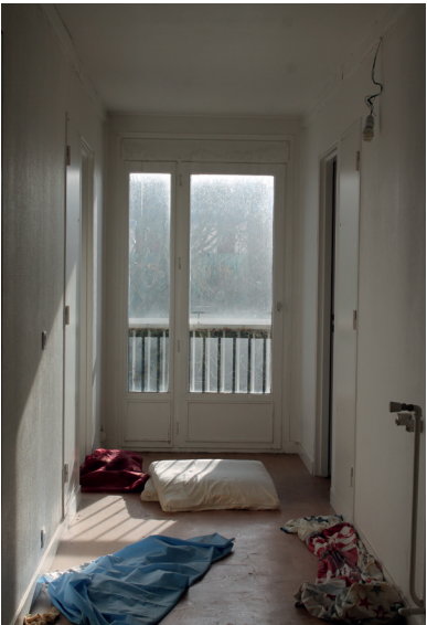
Couloir central du logement
