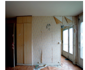
T2 n°304 - pièce de vie principale, avec vue sur la chambre
