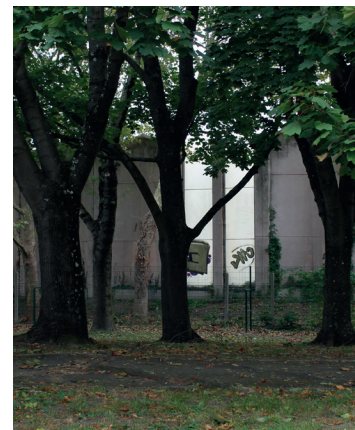
Le mur de protection acoustique, et les érables planes tentant de le dissimuler.
