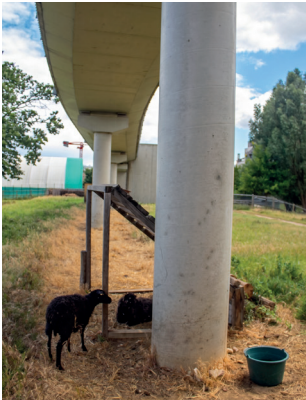
Partie écopaturage du site ; les moutons et leur enclos sous la passerelle
