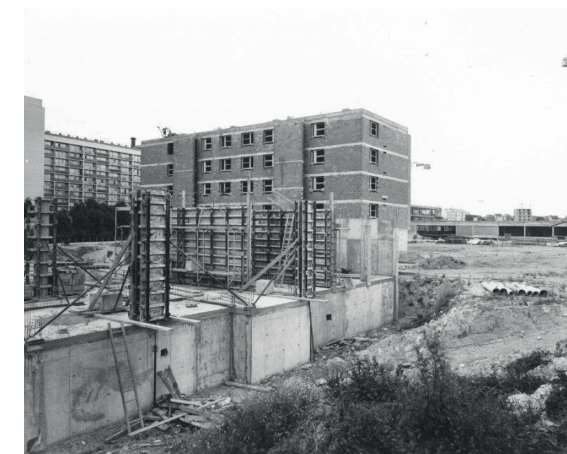
Construction du bâtiment F, pose des voiles porteurs du rez-de-chaussée, 1969. Archives AHP
