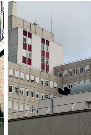
Détail sur la façade de la rotule de l'hôpital
