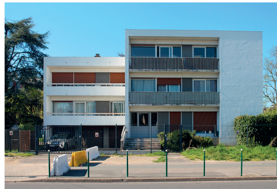
Façade sud depuis la rue des Renouillers du bâtiment LD. Photographie personnelle
