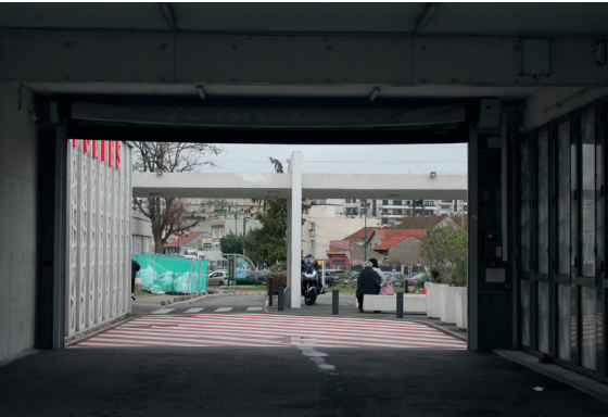
La passerelle d'accès ; vue depuis l'accès aux urgences
