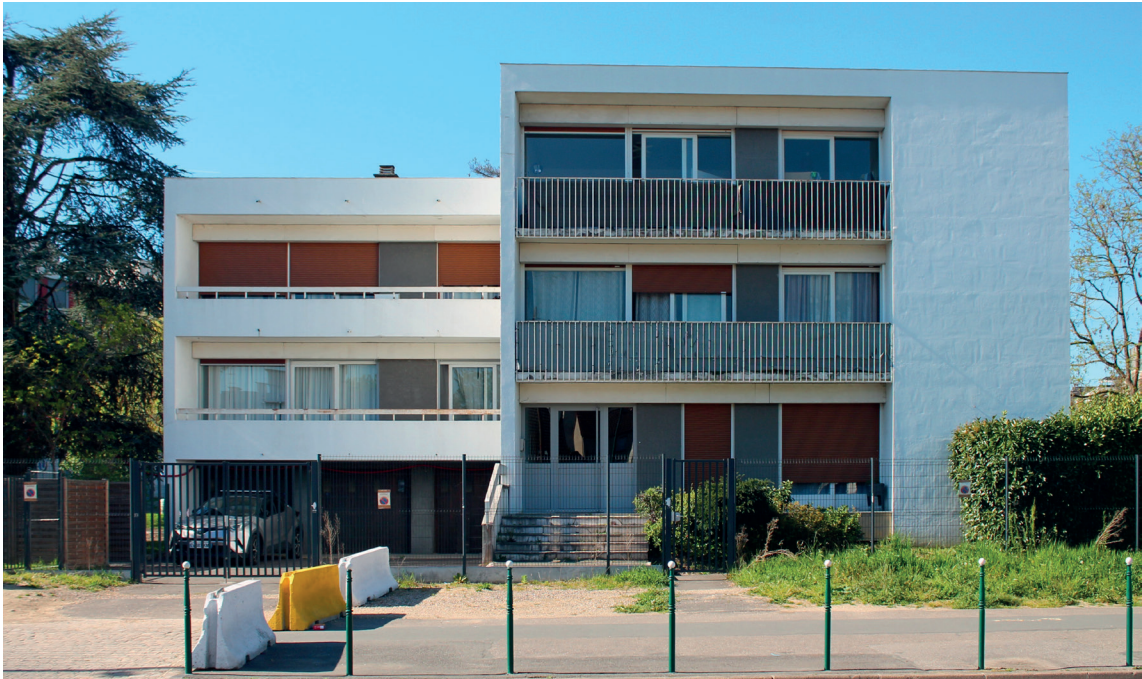
Façade sud du bâtiment LD
