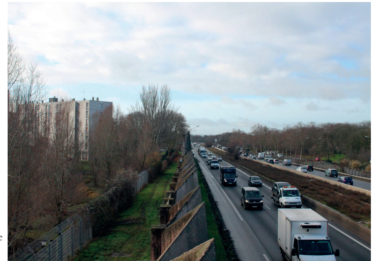
Interstices ; l'importance de l'autoroute A86 vis-à-vis du bâtiment F
