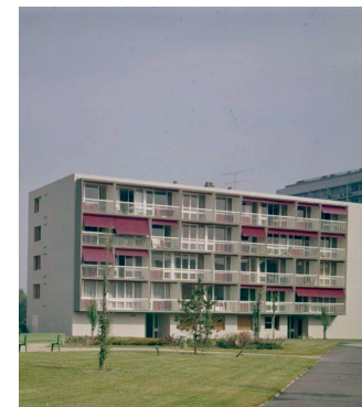
Le bâtiment L (anciennement logements pour personnels), 1971. Archives APHP
