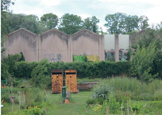
Potager partagé entre plusieurs associations ; omniprésence du mur de protection sonore
