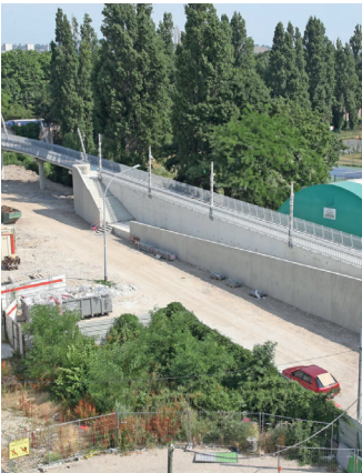
Construction de la passerelle rue de Frankenthal. MoDem Colombes, « Colombes : une passerelle sur l'A86 réaménagée », 15 août 2013
