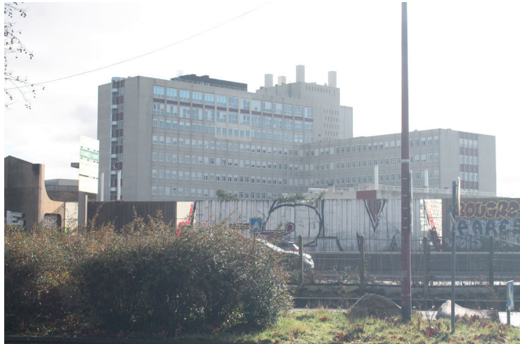
L'hôpital et sa présence dans le paysage environnant
