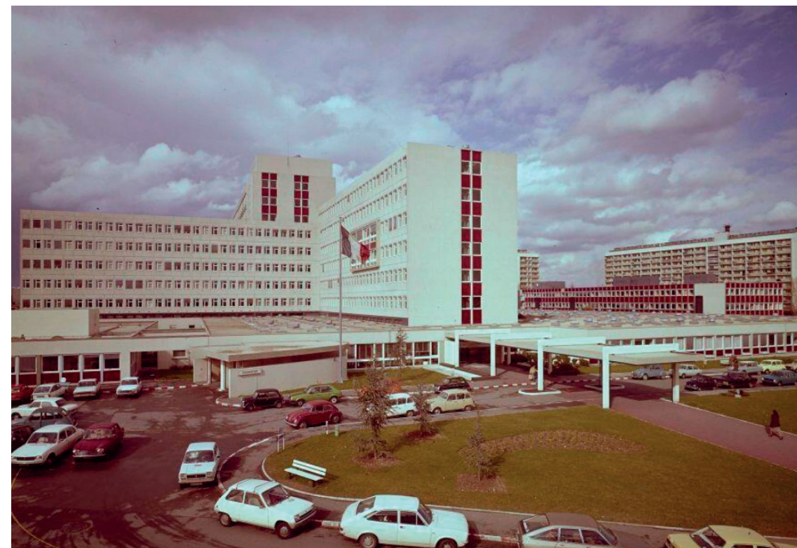
Photographie d'ensemble du bâtiment principal, 1978. Archives APHP
