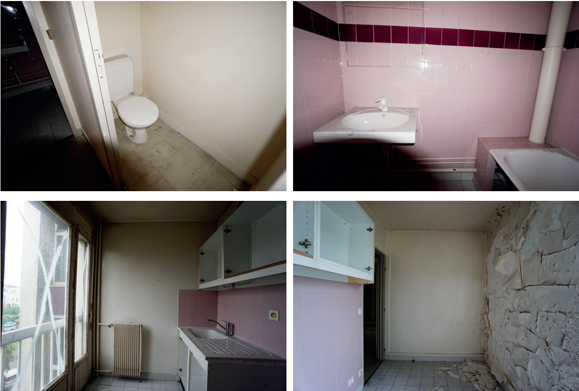
Les sanitaires séparés, la salle de bain et la cuisine
