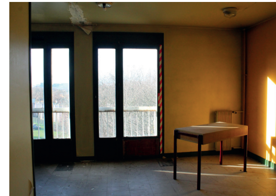
Espace commun ; un salle par étage
