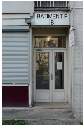
Entrée secondaire du bâtiment F ; accès à la seconde circulation verticale
