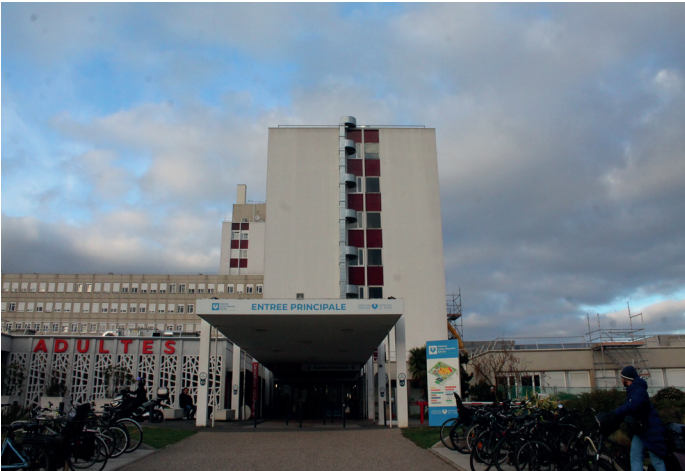
Façade principale de la rotule - entrée principale
