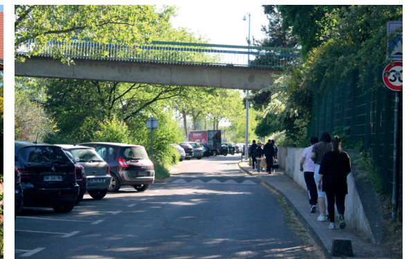
Passerelle au bout de la rue de Frankenthal, traversant l'A86, réalisée en 2013.
