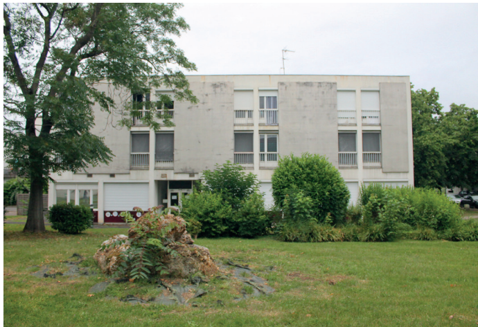
Façade ouest du bâtiment des internes
