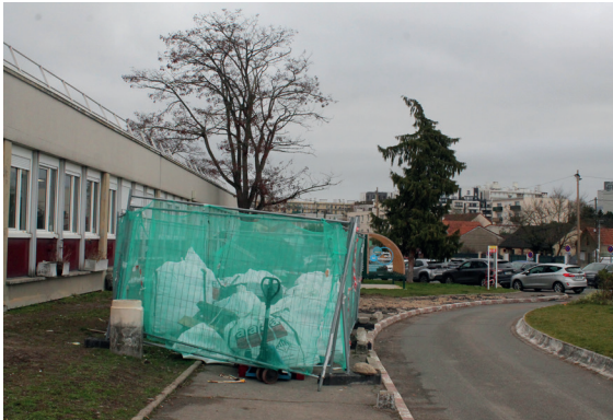
L'hôpital en constante transformation ; zone de travaux
