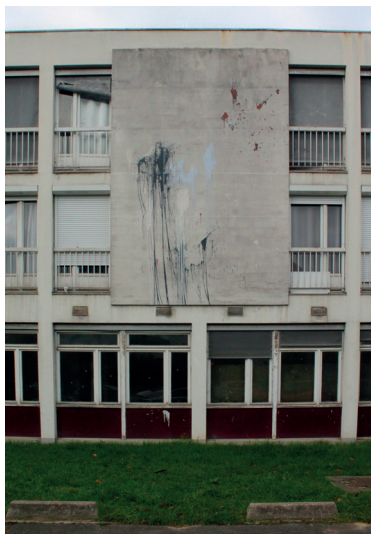
Façade est du bâtiment des internes
