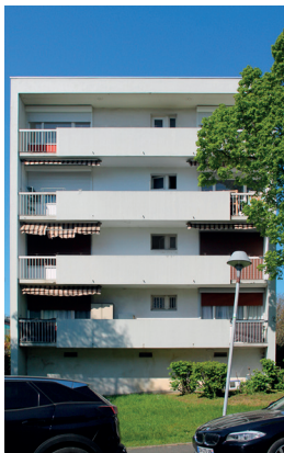
Façade est du bâtiment L
