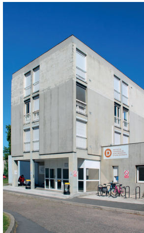
L'IFSI ; façade sud et entrée principale
