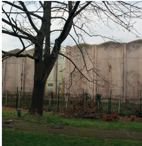
Le mur de protection acoustique et son rapport au parc
