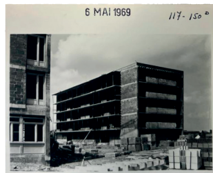
Construction du bâtiment F et L du site - 6 mai 1968. Archives de l'APHP
