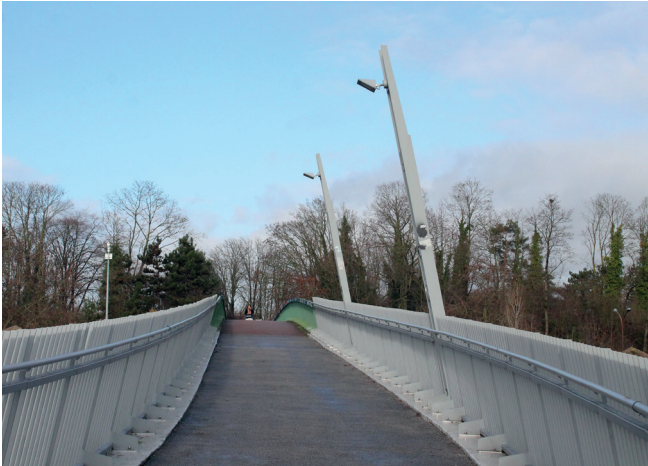
Passerelle Rue de Franckenthal
