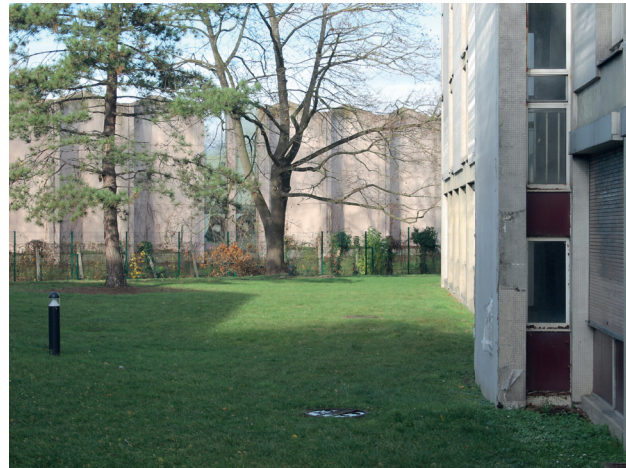
Le bâtiment F et son contexte
