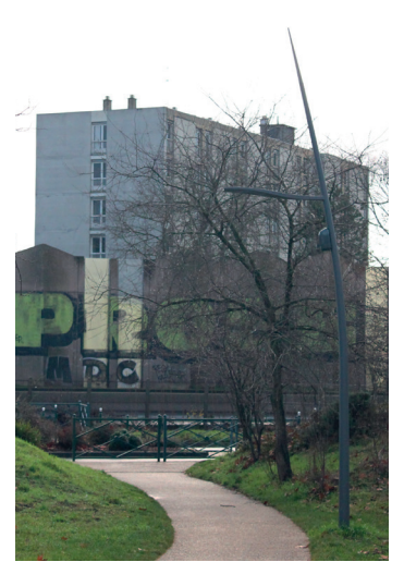
Vue sur le bâtiment F depuis le tennis club de Colombes
