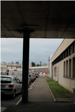
Le porche ; lien entre la rotule et le service technique
