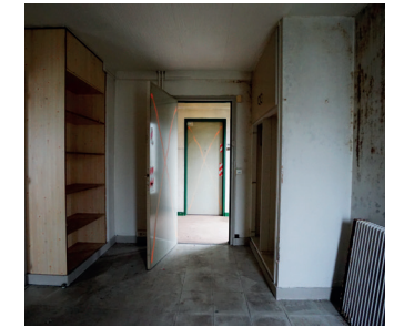
T1 n°310 - Vue depuis la pièce de vie sur l'entrée et ses différents placards
