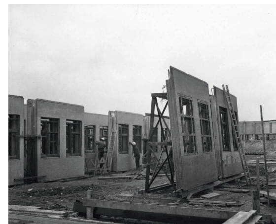
Blocs préfabriqués de la rotule principale, 1968. Archives AHP
