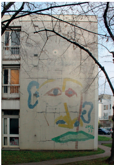
Détail de façade sud du bâtiment des internes
