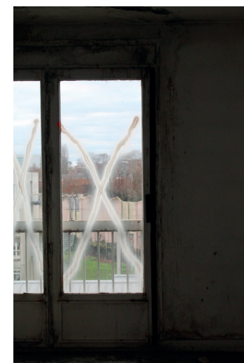
Photographie de la chambre n°407
