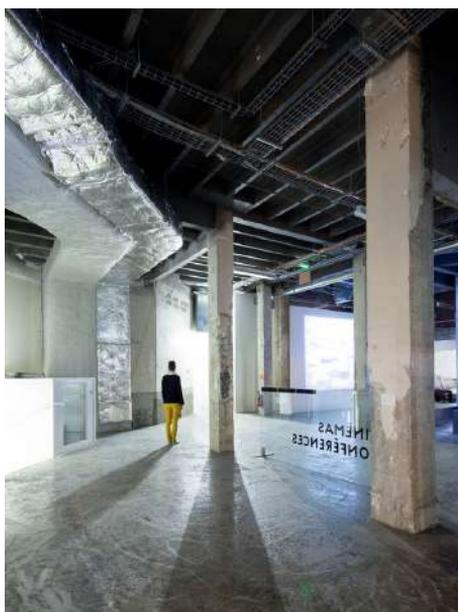
Figure 28 \_ **Structure en béton et métal, finitions brutes, réseaux techniques apparents**
